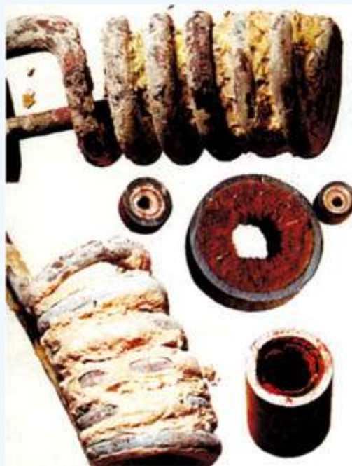
Obecne w wodzie sole wapnia i magnezu są przyczyną powstawania kamienia kotłowego
